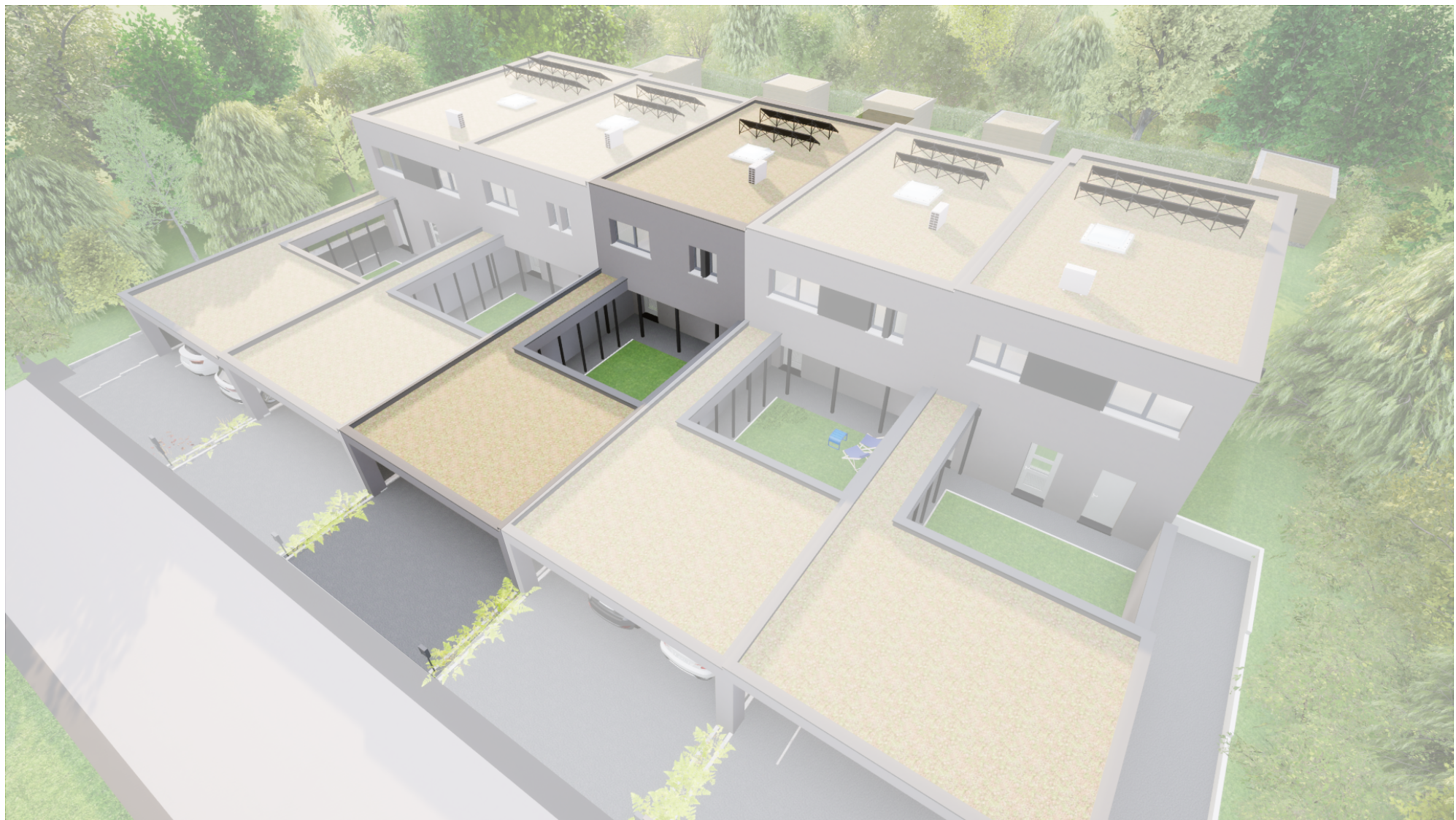
Vue d'ensemble lot 38 à 42
