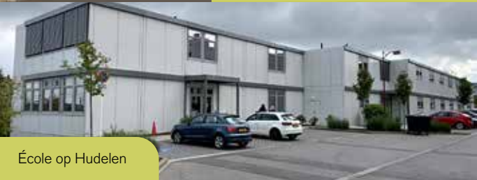
École Lydie Schmit (en construction)
