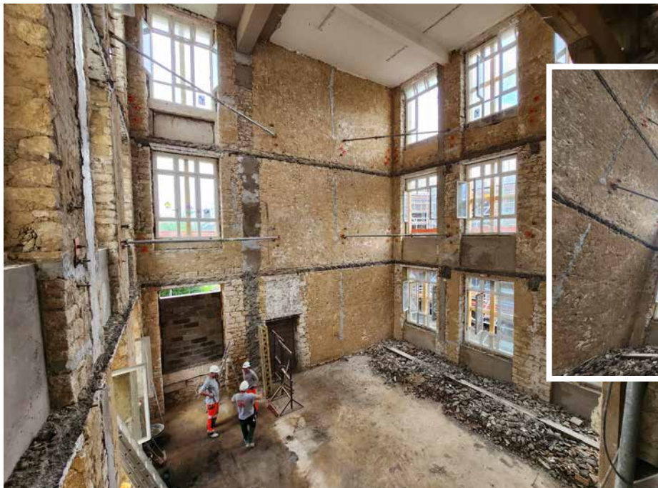
Entkerntes Gebäudeteil ohne tragende Wände oder Decken, Bild vom 29. Mai 2024. Partie du bâtiment démantelée sans murs porteurs ni plafonds, photo du 29 mai 2024.
