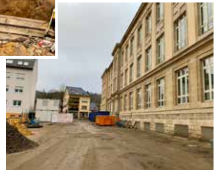
Lydie Schmit: Erdbauarbeiten des neuen Anbaus / Travaux de terrassement de la nouvelle annexe
