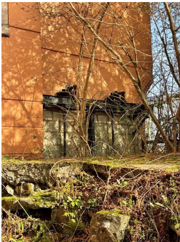
Fig. 37 : Vestiges d'une écluse scellée avec des briques en béton (Luxembourg, 2022). (Photo : HLG ingénieurs conseils sàrl).
