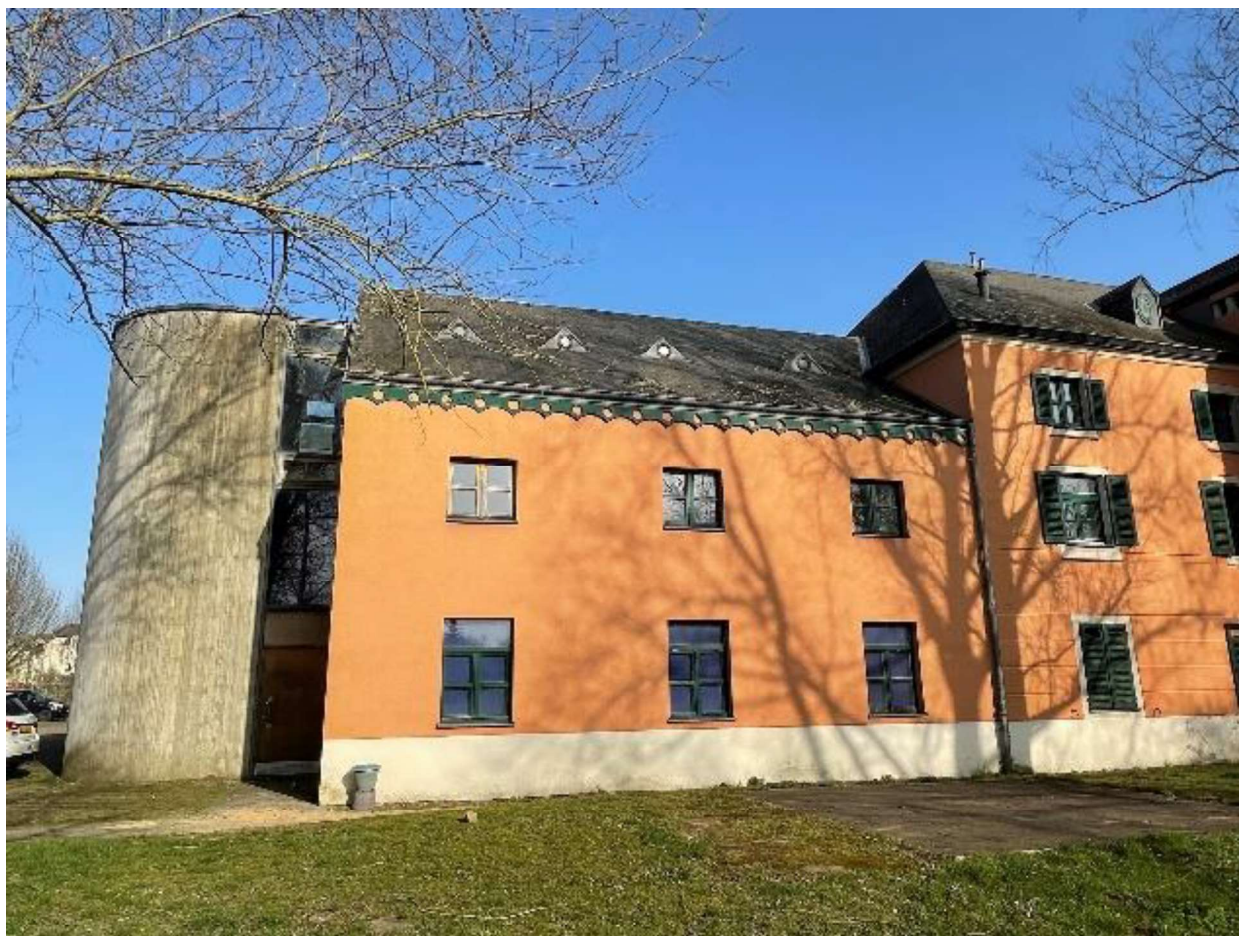
Fig. 39 : L'arrière de l'annexe qui est attaché au bâtiment principale (Luxembourg, 2022). (Photo : HLG ingénieurs conseils sàrl)
