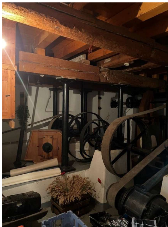
Fig. 41 : L'espace du rez-de-chaussée qui contient les anciennes machines du moulin (Luxembourg, 2022). (Photo : HLG ingénieurs conseils sàrl).
