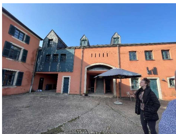
Fig. 36 : Bâtiment annexe du Moulin Bestgen (Luxembourg, 2022). (Photo : HLG Ingénieurs Conseils sàrl)
