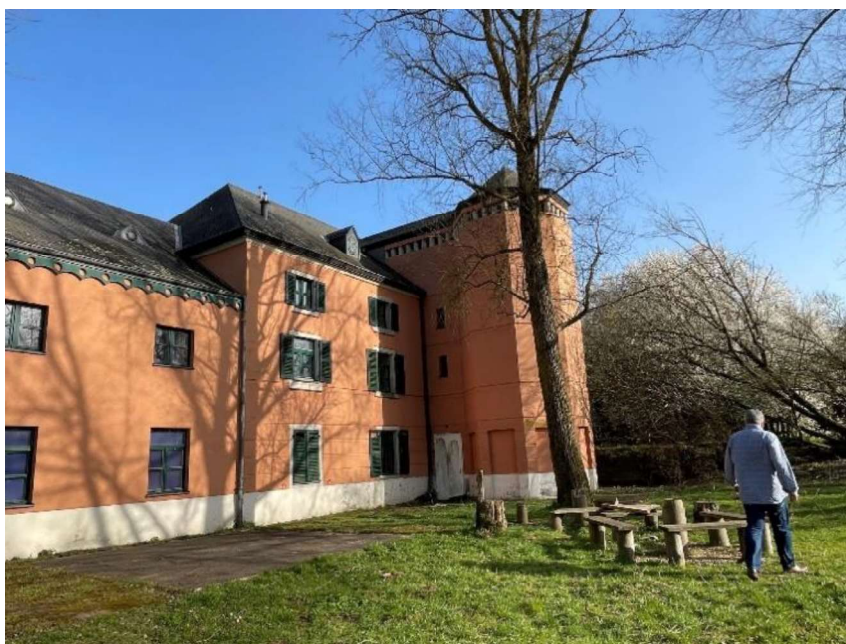
Fig. 38 : Le bâtiment principale de l'arrière (Luxembourg, 2022). (Photo : HLG ingénieurs conseils sàrl)
