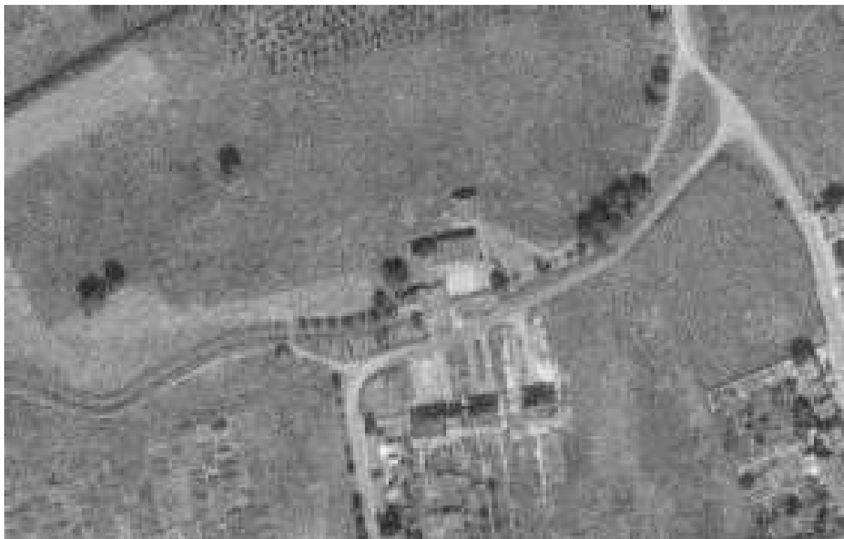
Fig. 14 : Extrait détaillé du moulin, vue aérienne (Luxembourg 1963). © Géoportail
