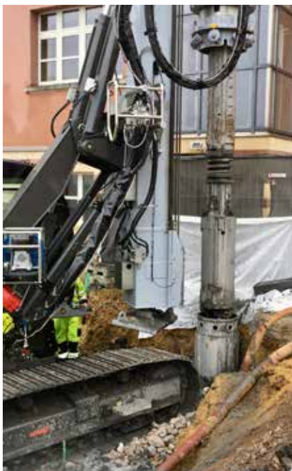
Albert Wingert Neubau - Pfahlgründung / Fondation profonde
