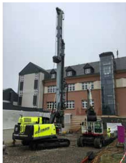
Albert Wingert Neubau - Pfahlgründung / Fondation profonde
