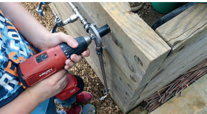
Wasserhähne werden angeschlossen | Installation des robinets
