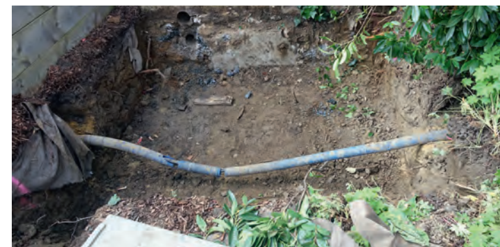
Loch gegraben für den Wassertank | Creuser un trou pour le réservoir d'eau
