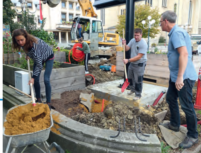
Umgraben des Gartens um die Anschlüsse zu legen | Béchage du terrain pour l'installation des raccords
