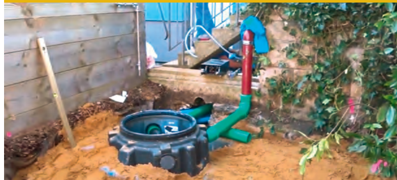
Einsetzen des Regenwassertanks | Mise en place du réservoir d'eau de pluie
