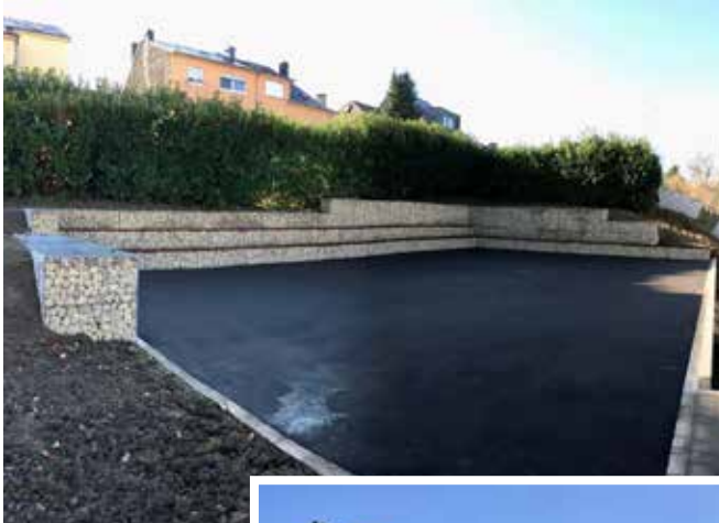
Albert Wingert Fußballfeld mit seinen Terrassen aus Gabionen
